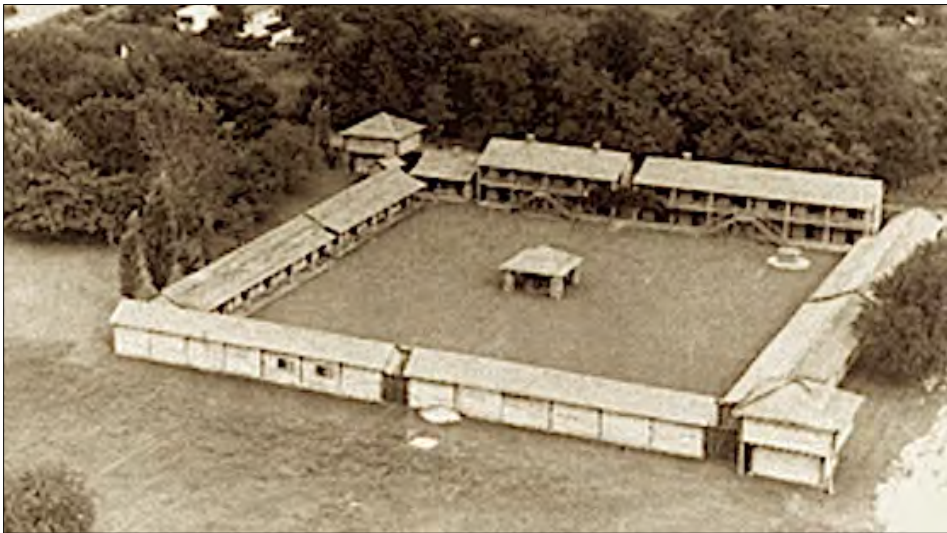
Sur bases des anciens plans du fort Gibson, sa reconstruction a été effectuée sur les lieux de son emplacement originel et en respectant le positionnement et le conditionnement de ses bâtiments en briques et en bois (H.H.H. Heroes & Heroines & History- Fort Gibson Historical Site).
